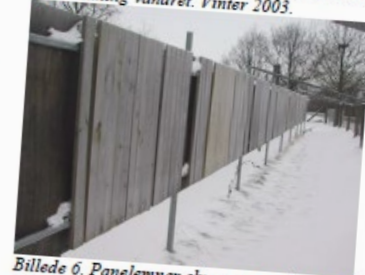
Billede 6. Panelemner eksponeret uden overdækning lodret mod nord. Vinter 2003.
